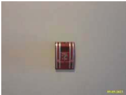
อุปกรณ์แจ้งเหตุเพลิงไหม้แบบกด (Manual Station)
